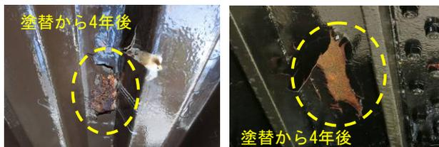
図-2 塗替後の塗膜はがれ
