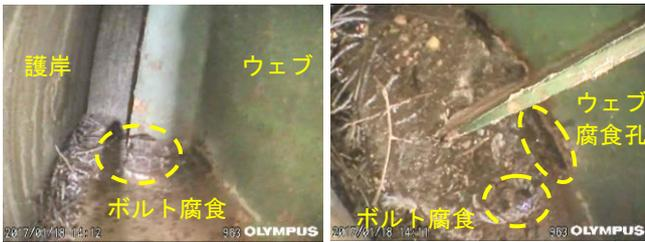
図-6 桁端部の腐食
