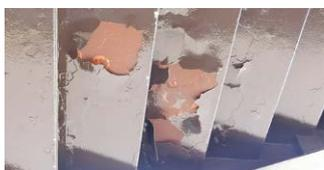
図-13 旧塗膜に起因する塗膜の剥がれ
