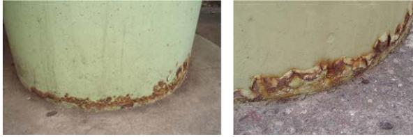
図-10 鋼製橋脚地際部の腐食
