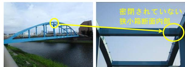
図-4 人道アーチ橋上横構の箱断面
