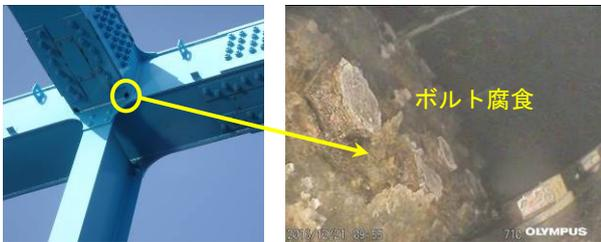
図-7 狭小箱断面内部のボルト腐食
