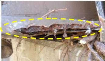
図-11 主桁の塗膜下腐食
