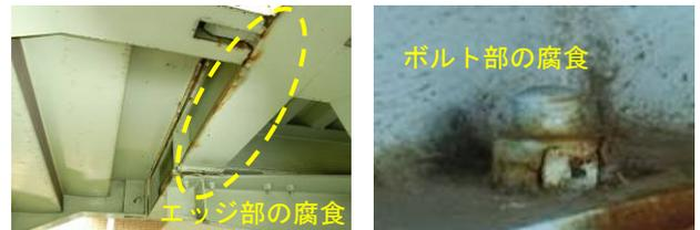
図-9 エッジ部の腐食, ボルト部の腐食
