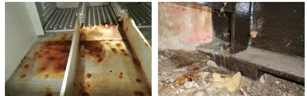
図-8 箱桁内部の腐食, 桁端部の土砂溜まり
