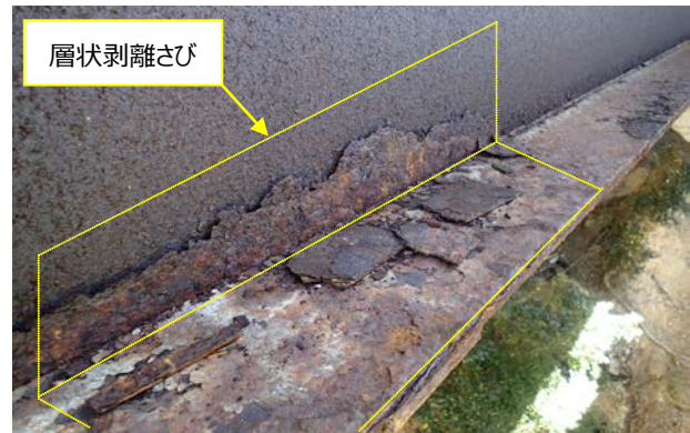
図-1 層状剥離さびの発生例 (外桁ウェブ及び下フランジ)
