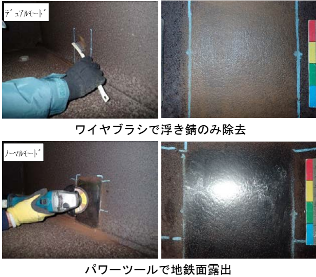
図-5 前処理の実施状況および測定面の状態
