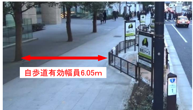
写真-7 ステーション設置後の自歩道有効幅員
