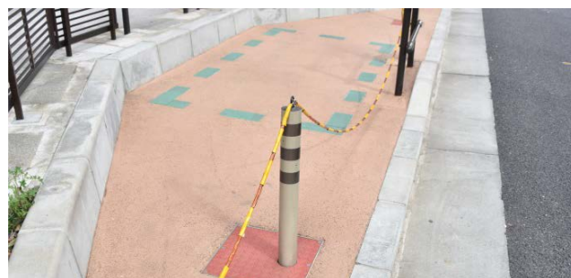
写真-4 カーシェアステーション（内部の色彩）
