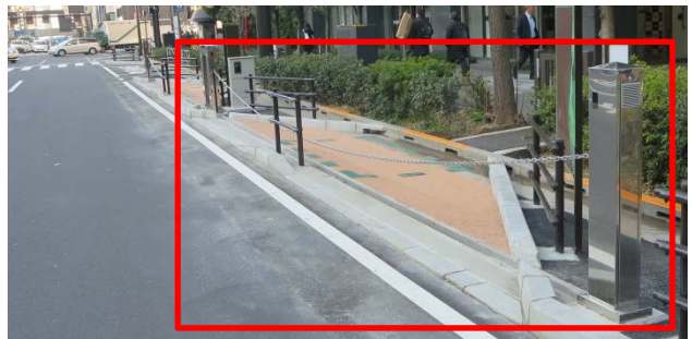
写真-11 ロボットゲート
