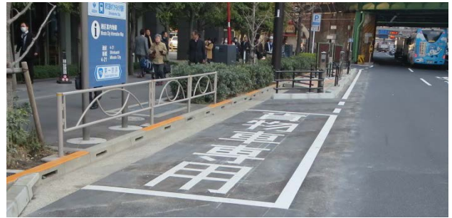
写真-9 荷捌きスペース
