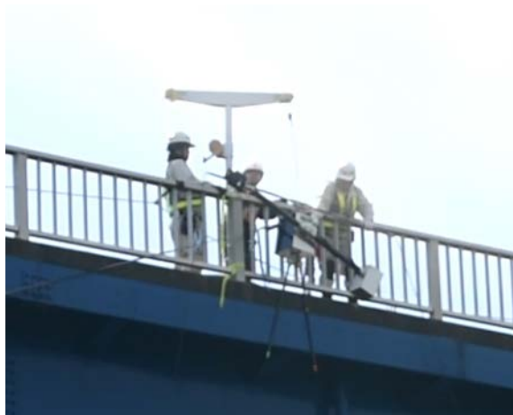
図-5 ホイストを使用した点検ユニットの吊り下ろし状況
