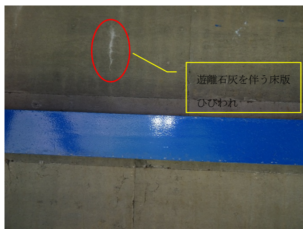
図-7 RC床版のひびわれ状況
