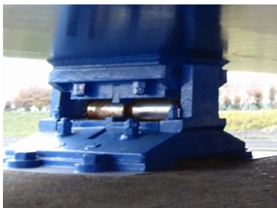
図-11 鋼製支承カバーの紛失状況
