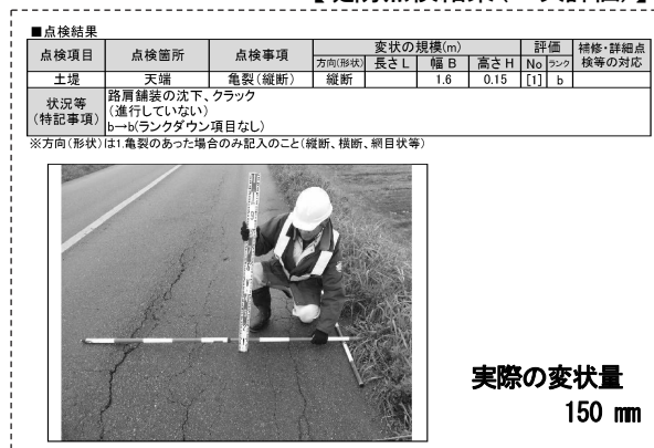
図-7 河川 CIM モデルと堤防点検結果の変状量比較
