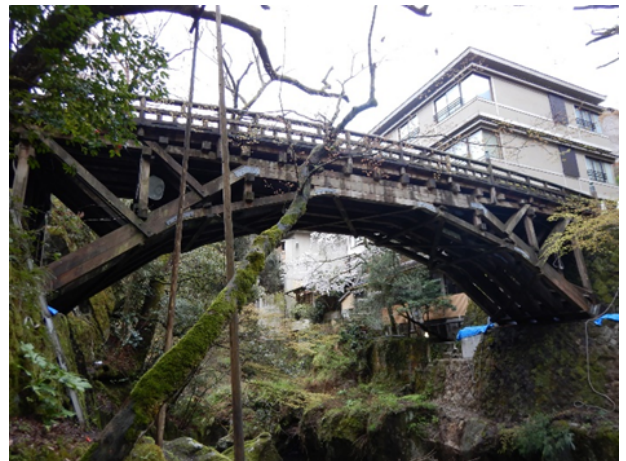
写真-1 こおろぎ橋
