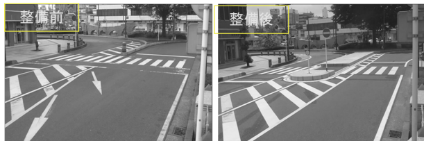
（左：安全島整備前，右：安全島整備後）
