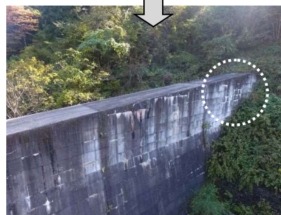
写真-4 C堰堤における本堤のひび割れ・劣化状況
