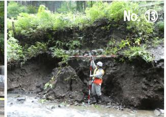
写真-7 護岸洗堀の顕在化
