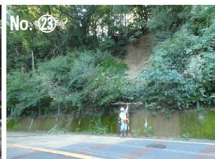
写真-5 本線近接斜面の崩壊
