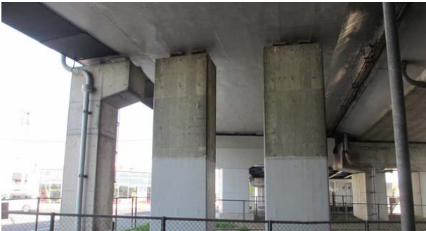
図-11 現橋支承部
