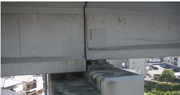
図-3 桁遊間 (かけ違い橋脚部)
