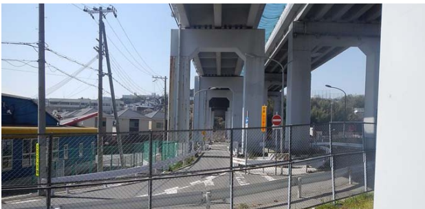
図-2 橋脚周辺状況
