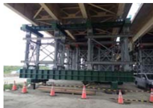
(d) 応急復旧状況
