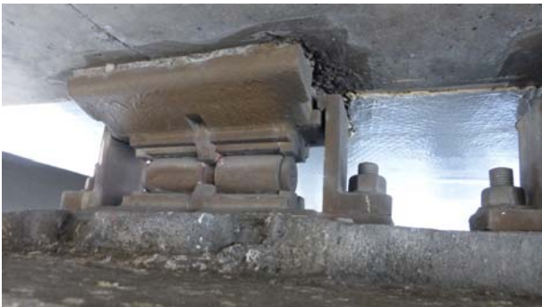
図-12 既設支承（一本ローラー支承）
