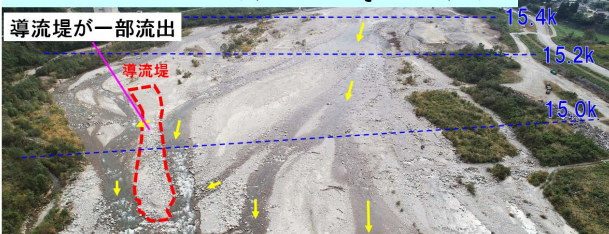
図-4 UAVによる導流堤周辺の河道変化
