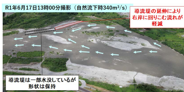
図-9 導流堤付近のUAV空撮画像 (R1.6洪水中)
