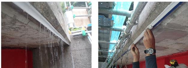
図-8 ウォーターカッター（水切り材）の設置状況
