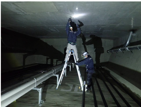
写真-1 桁高が高いPC箱桁内部の近接目視点検状況
