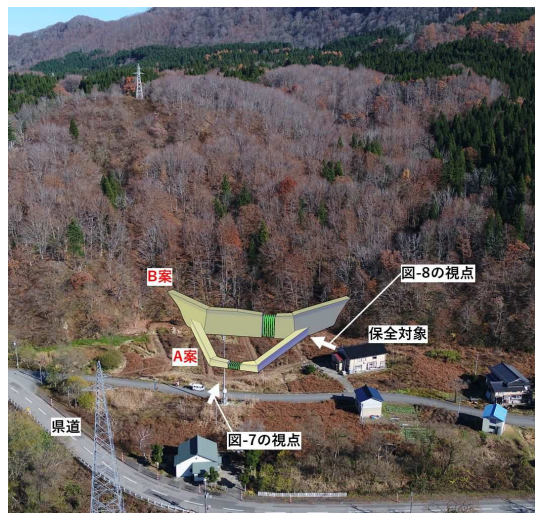
図-6 予備設計の堰堤配置イメージ(UAV写真)
