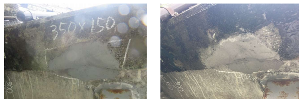
図-4 定期点検時の簡易補修（左：R3.8/右：R4.7）
