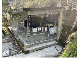
写真-3 新発電所建屋
