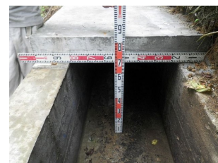
写真-6 導水路(改修後)
