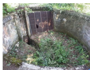
写真-7 ヘッドタンク(改修前)
