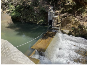
写真-2 新取水堰堤
