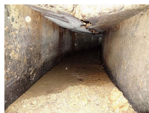
写真-5 導水路(改修前)
