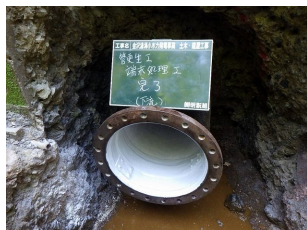
写真-9 水圧管路(管更生後)
