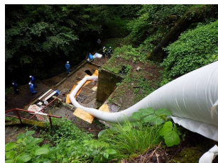
写真-10 施工状況
