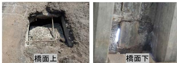
図-1 床版の抜け落ち事例
