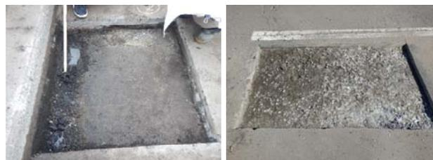
図-2 床版上面の砂利化事例
