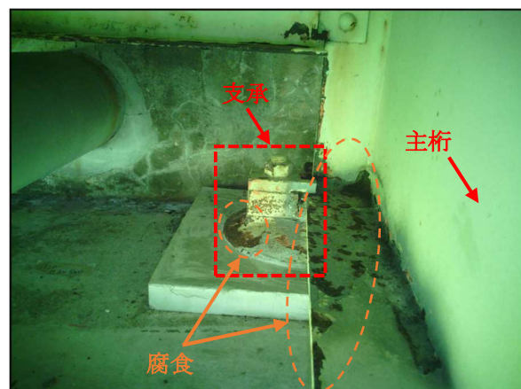
写真-2 IoTカメラによる支承の画像（7/23 12時）
