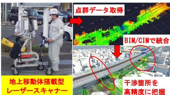
図-2 地上移動体搭載型レーザースキャナーによる測量
