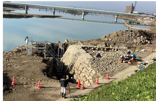
写真-2 丸ばね開削調査状況
