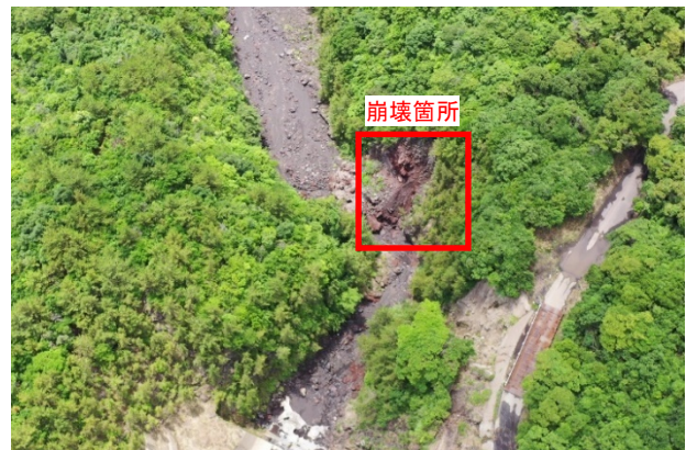
図-4 崩壊・侵食等の変状（教師データ）事例
