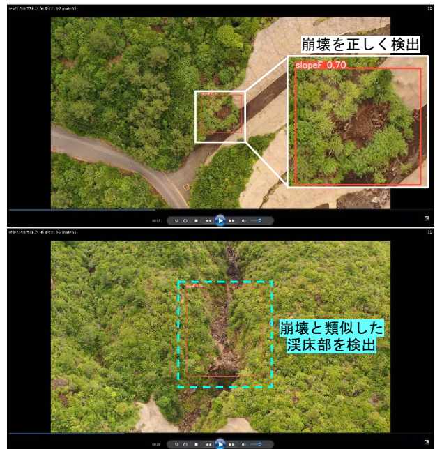
図-9 AIモデルによる崩壊検出結果 (上：崩壊を正しく検出， 下：崩壊と類似した溪床部を検出)
