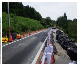
写真-4 応急復旧路面写真
