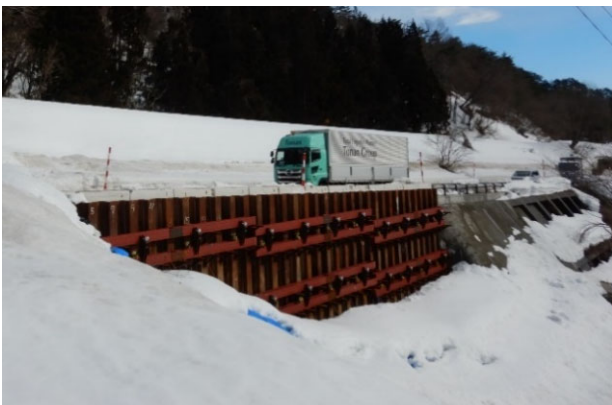
写真-7 対策工事 施工完了
