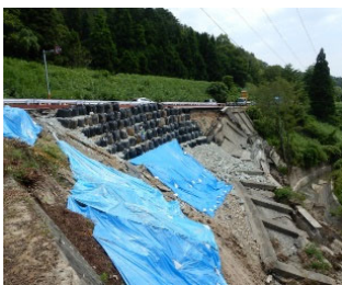
写真-3 応急復旧側面写真
