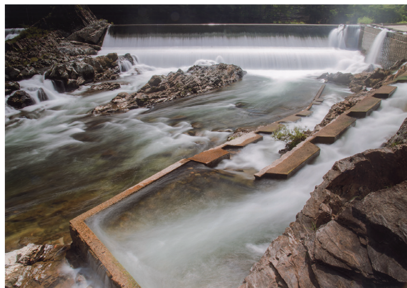
「魚道」 愛知県 嶋田 茂雄 (撮影地：愛知県新城市)
