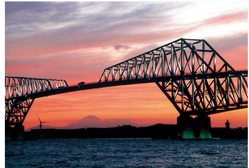
「夕景に浮かぶ」 東京都 古畑 耕 (撮影地：東京都江東区)
