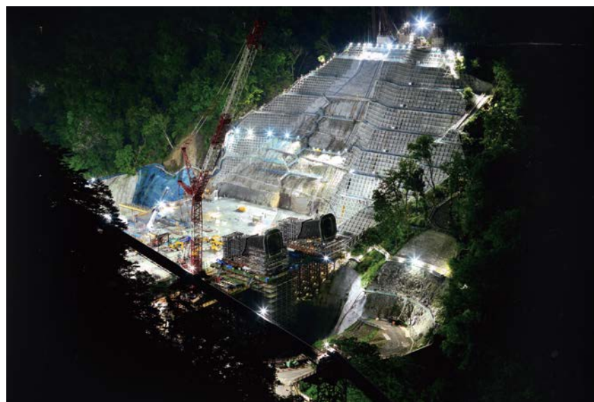
「ハッ場ダム昼夜施工決行中」
