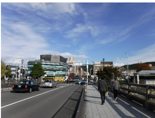
京阪本線の地下化により東山方面の景観が守られている。
