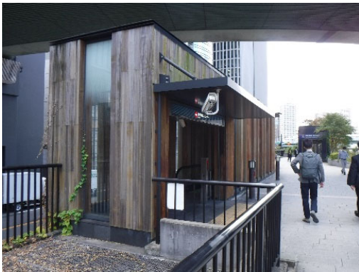
水辺のロケーションを意識した駅への出入口 (渡辺橋駅)
