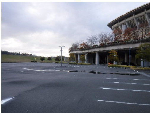
鶴見川多目的遊水地 日産スタジアムの駐車場として利用
