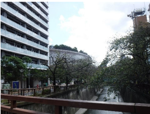
大橋ジャンクション 遠景 (国道 246 号方面より撮影)
