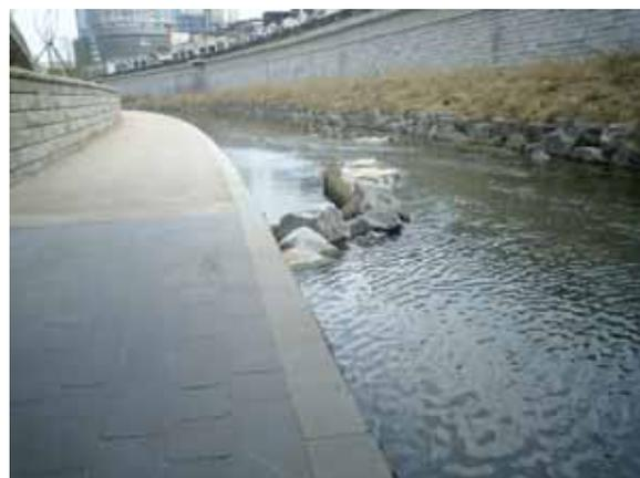
きれいな街橋付近の水制。石組みで流向を変え、水辺に変化を与えている。
