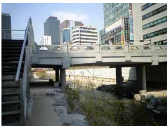
長通橋を下流側から。
