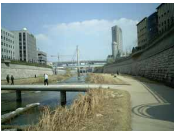
ドゥムル橋を上流側から。
