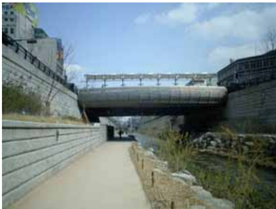
観水橋を上流側から。
