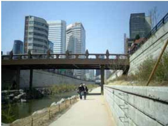
水標橋を下流側から。
