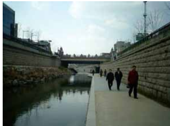
馬廬橋を下流側から。
