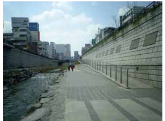
世運橋を下流側から。
