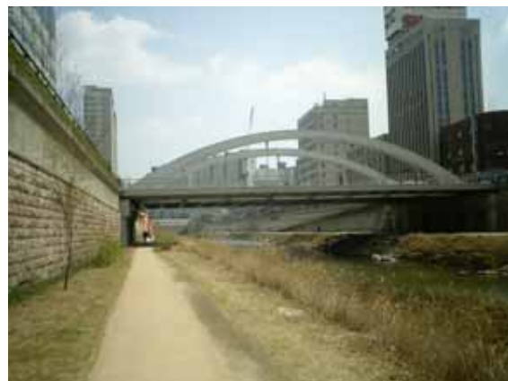
庇雨堂橋を上流側から。
