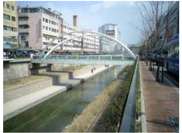
マルゲンネ橋を上流側から。
