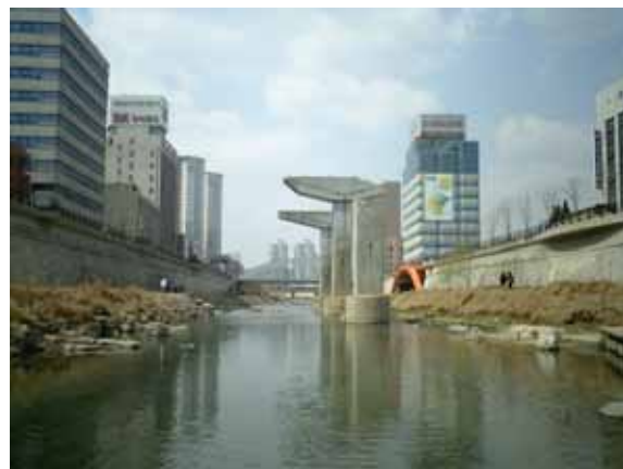
庇雨堂橋下流の存置橋脚を下流側から。かつての高速道路の橋脚をモニュメントとして残している。撮影は河道内に設置された栈橋から。
