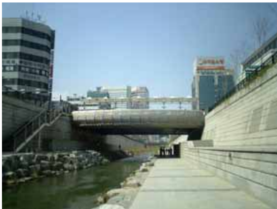
観水橋を下流側から。
