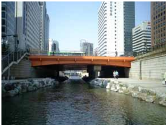
広橋を下流側から。
