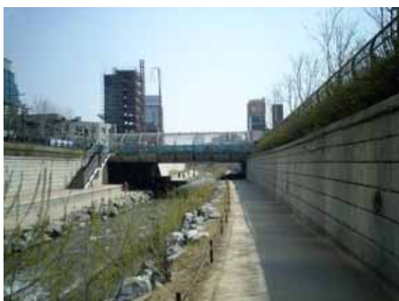
三一橋を上流側から。
