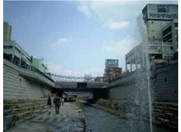
世運橋を上流側から。
