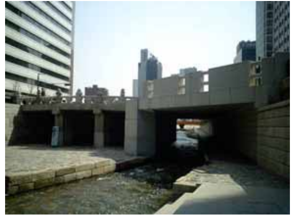
広通橋を上流側から。
