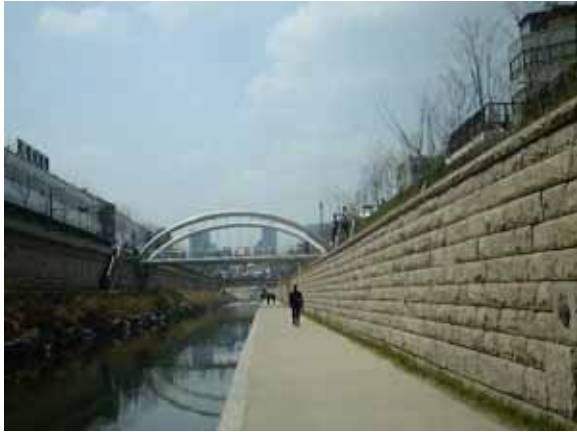
ナレ橋を下流側から。
