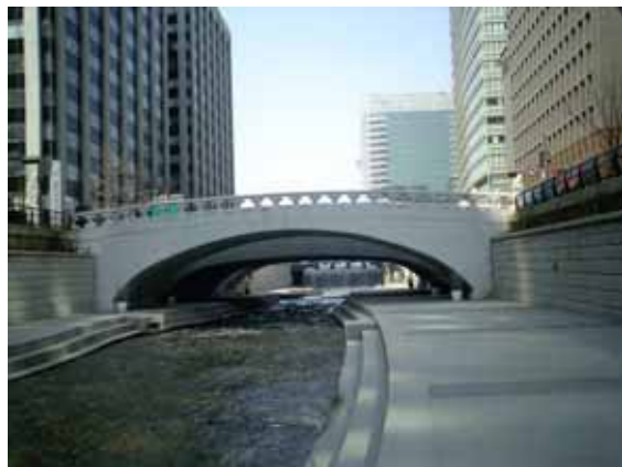
毛塵橋を下流側から。橋下から水面までが近い 印象を受けた。
