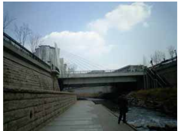
茶山橋を上流側から。
