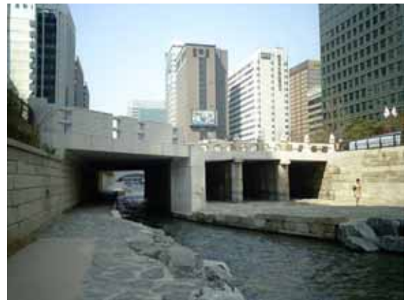
広通橋を下流側から。
