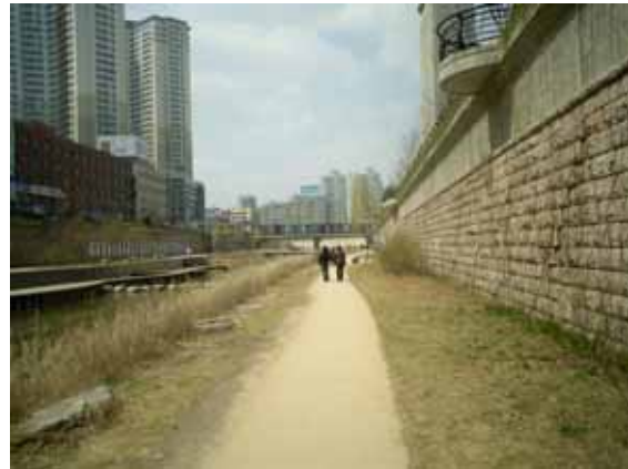
黄鶴橋を下流側から。河道内には飛び石や木の 栈橋が設置されており、水辺へのアクセスは容易。
