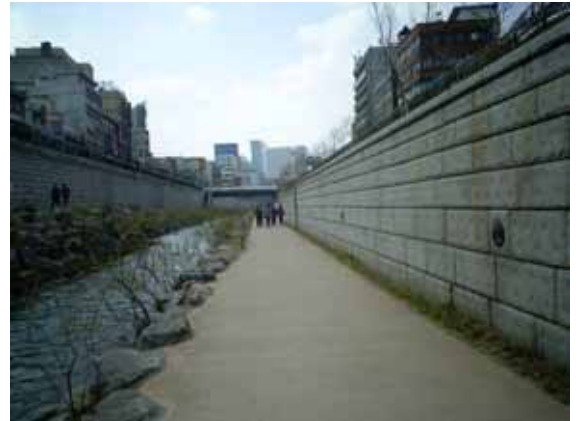
ベオゲ橋を下流側から。
