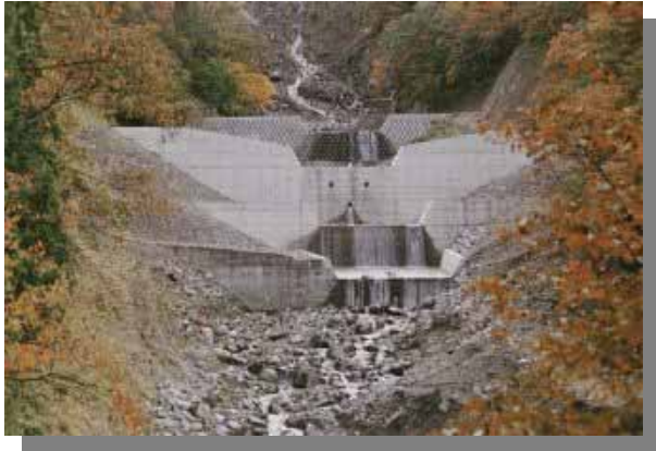
出典：平成7年7月長野県北部 梅雨前線豪雨災害復旧の記録， 長野県土木部
