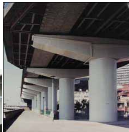
既存の柱を補強した例
