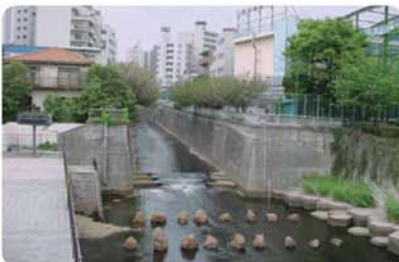
コンクリート張りの川
