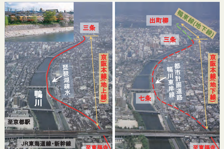
写真3 【事業前】 事業区間全景（左上写真は鴨川堤を運行する京阪電車）
