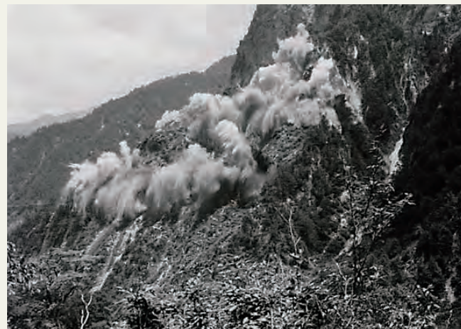
写真7 起死回生の坑道式発破（大発破）
