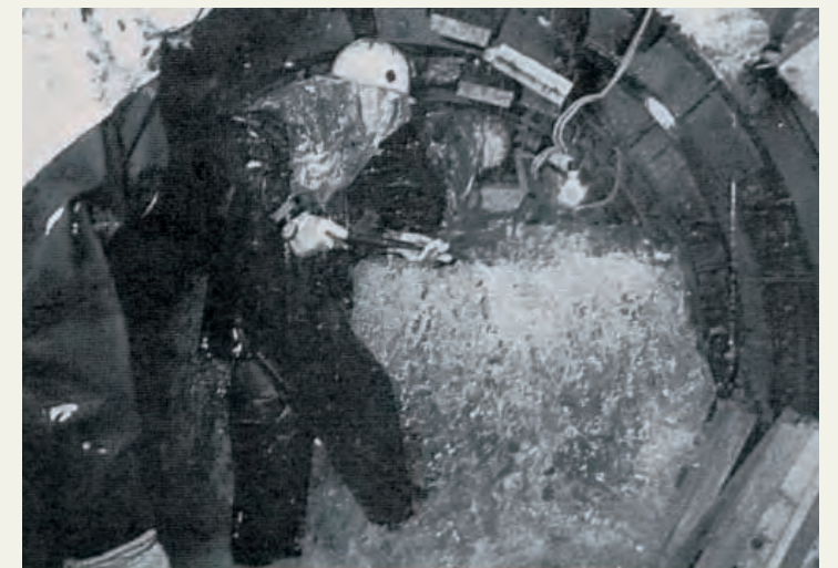
写真4 破碎帯水抜きトンネル（水温4℃の湧水）
