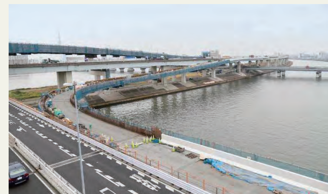
写真8 小松川JCT 施工状況 2018（平成30）年撮影
