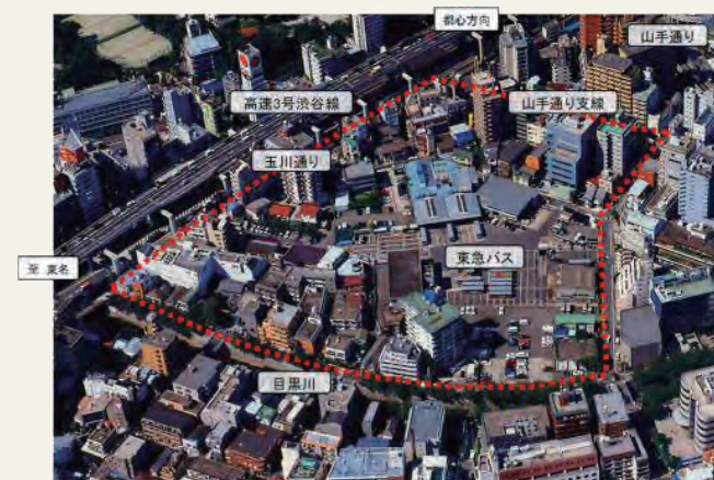
図8 大橋地区（1999（平成11）年撮影）
