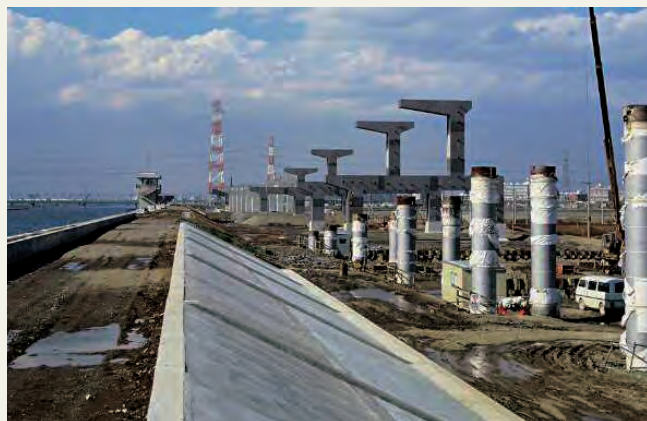
写真1 葛飾江戸川線 中堤での施工状況
