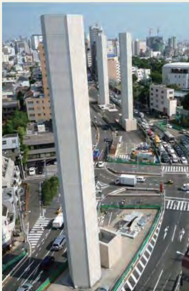
写真6 中央環状線神山町換気所 2010（平成22）年撮影
