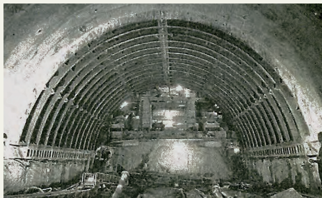
写真7 ルーフシールド施工状況
