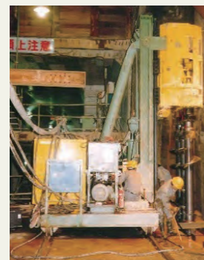
写真6 低空頭SMW掘削機
