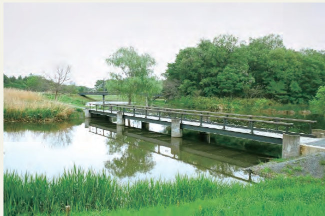
写真5 御所沼をわたる相ノ谷橋
