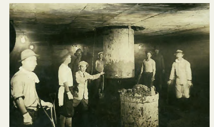
写真6 函内掘削状況
