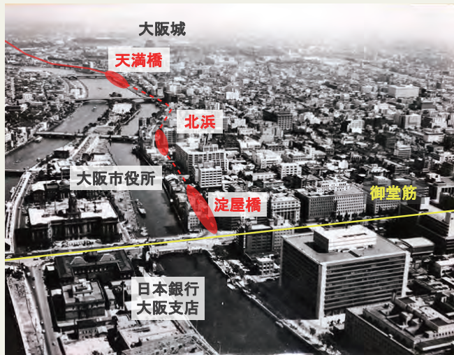
写真2 淀屋橋延長線の周辺状況
