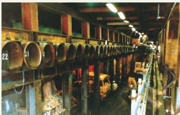
写真5 パイプルーフ工法
