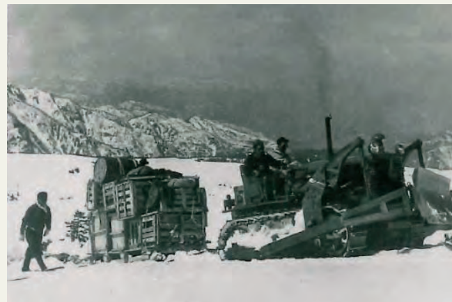
写真6 立山越えで資機材を雪上運搬
