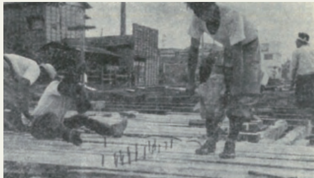
写真4 覆工板設置状況
