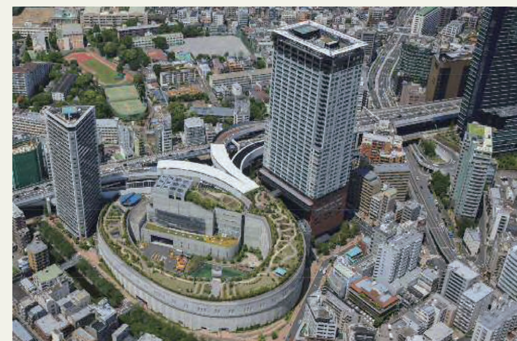
写真4 大橋JCT 航空写真（2016（平成28）年撮影）
