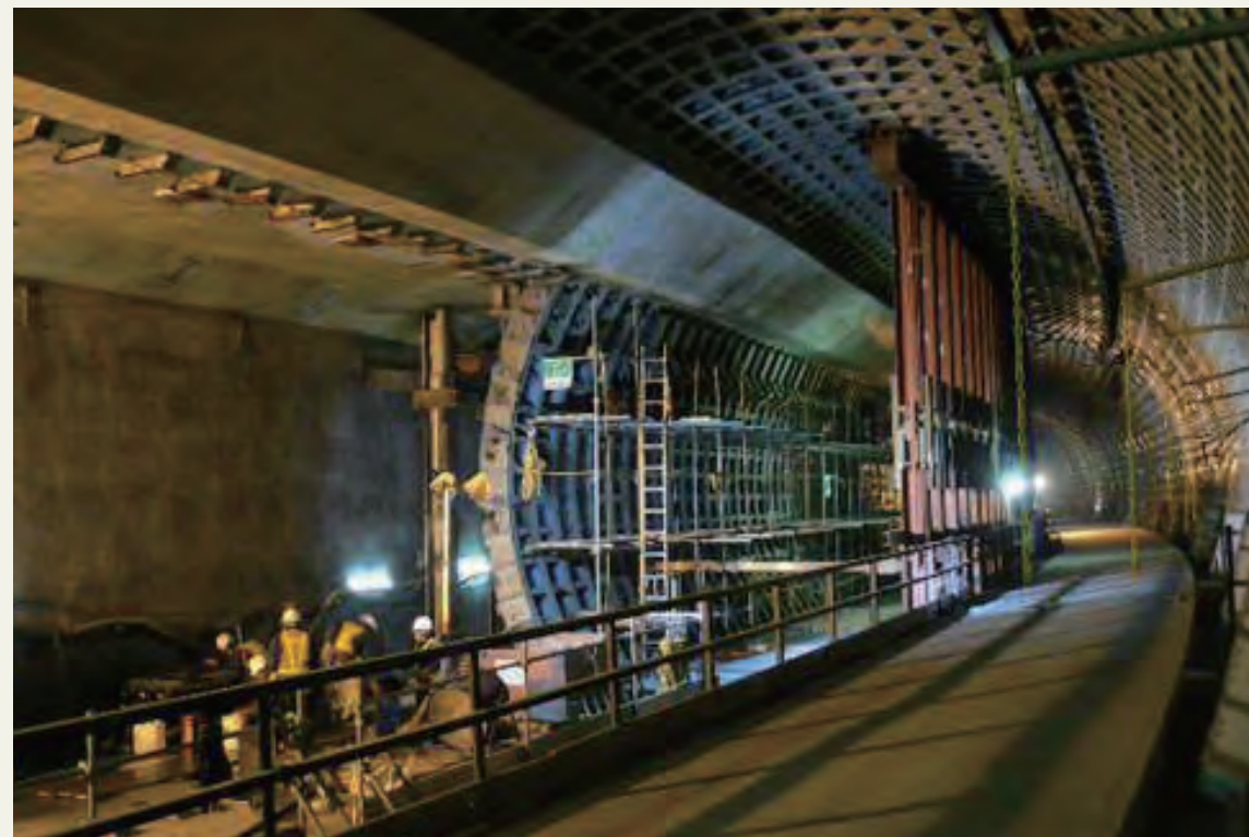
写真3 切開き工法（西新宿JCT 合流部）
