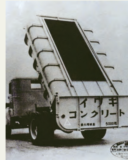
写真5 生コン運搬車
