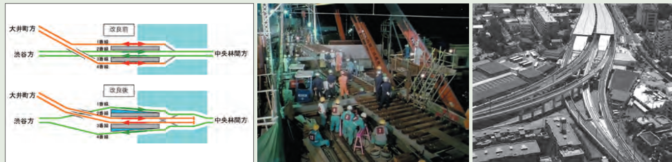
図4 二子玉川駅改良工事
