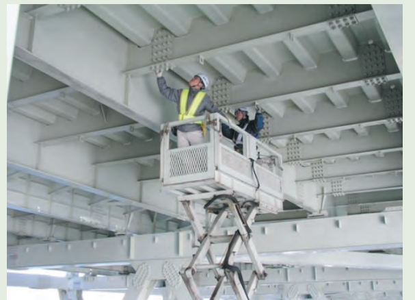
写真15 瀬戸大橋の点検作業
