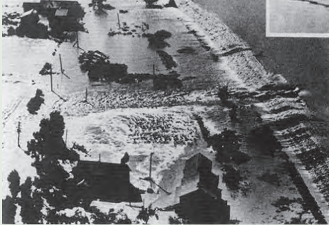
写真1 石狩川1975（昭和50）年洪水の越水状況
