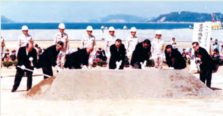
写真3 瀬戸大橋の起工式
