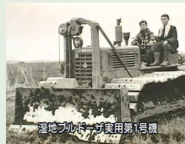
写真4 実用化した湿地ブルドーザ
