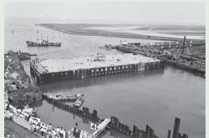
写真2 羽田トンネル（沈埋函工法）
