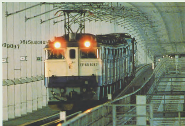
写真13 列車走行試験時の吊橋のたわみ
