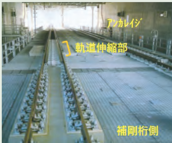
写真11 緩衝桁軌道伸縮装置
