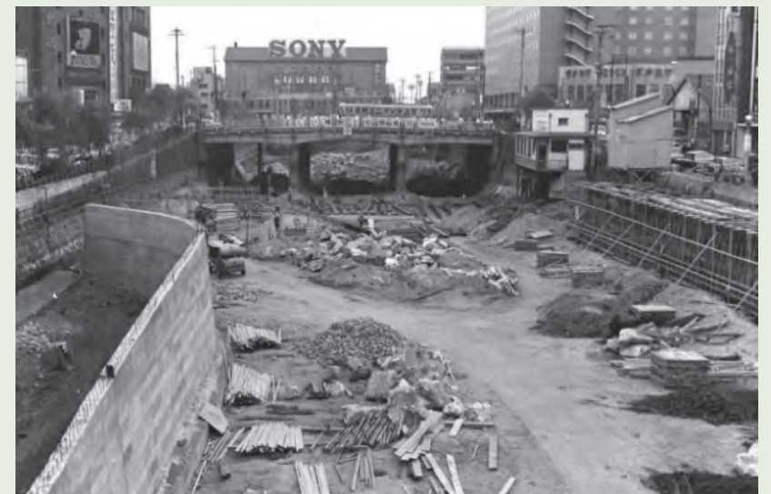
写真3 築地川・楓川区間（掘割構造）
