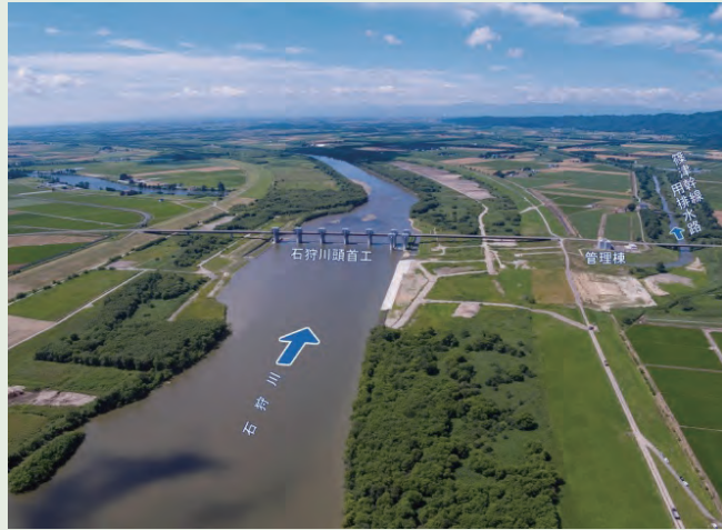
写真5 改築された石狩川頭首工の全景 (堰長257m、最大取水量37.49m³/s)
