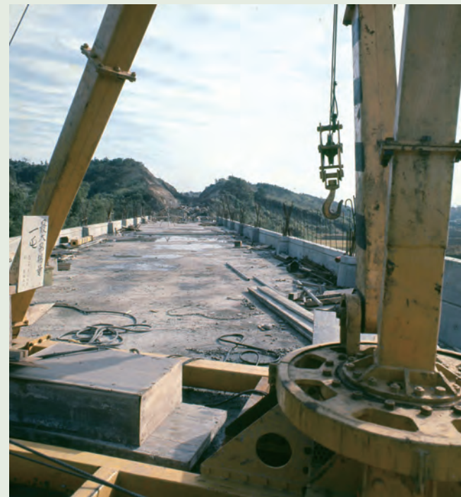
写真4 田園都市線建設工事（1965（昭和40）年頃）
