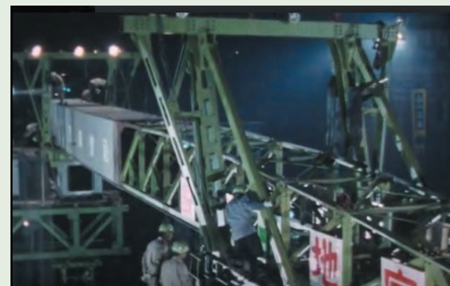
写真9 主桁架設手延べ工法
