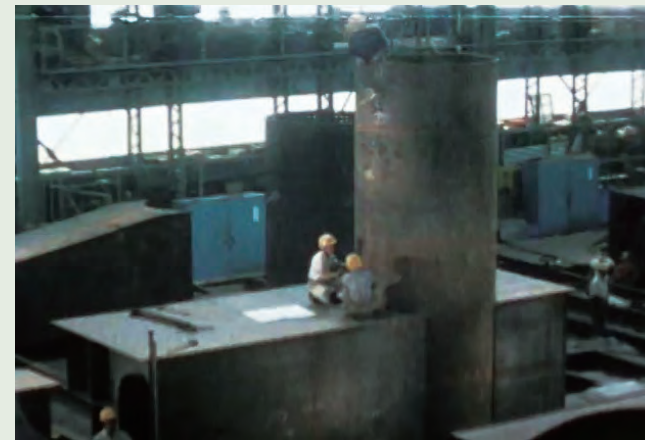
写真6 橋脚隅角部製作状況
