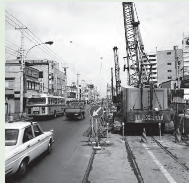
写真6 新玉川線建設工事（1970（昭和45）年頃）
