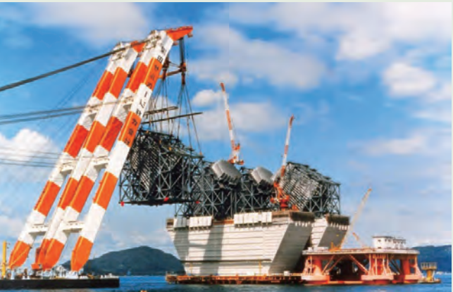
写真5 ケーブルアンカーフレームの一括架設（4A）
