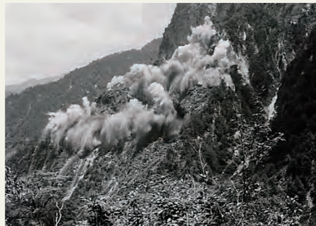
写真7 起死回生の坑道式発破（大発破）
