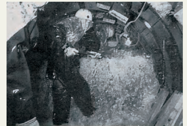
写真4 破碎帯水抜きトンネル（水温4℃の湧水）
