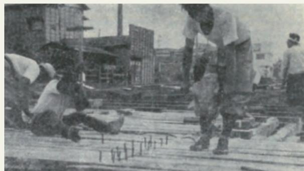
写真4 覆工板設置状況
