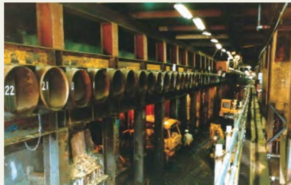
写真5 パイプルーフ工法
