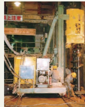
写真6 低空頭SMW掘削機
