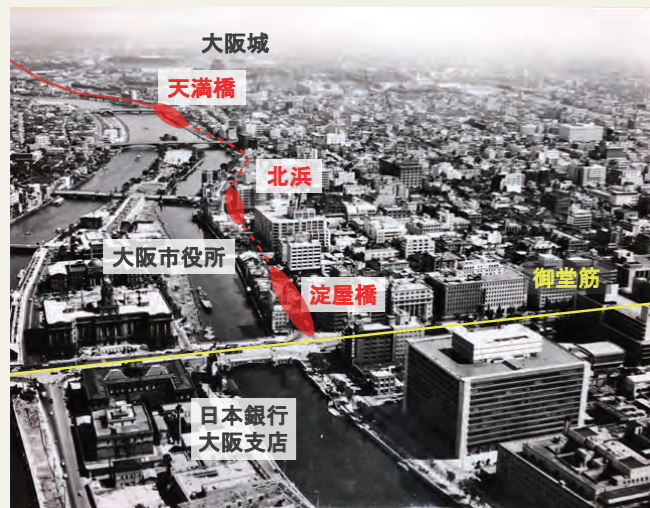
写真2 淀屋橋延長線の周辺状況
