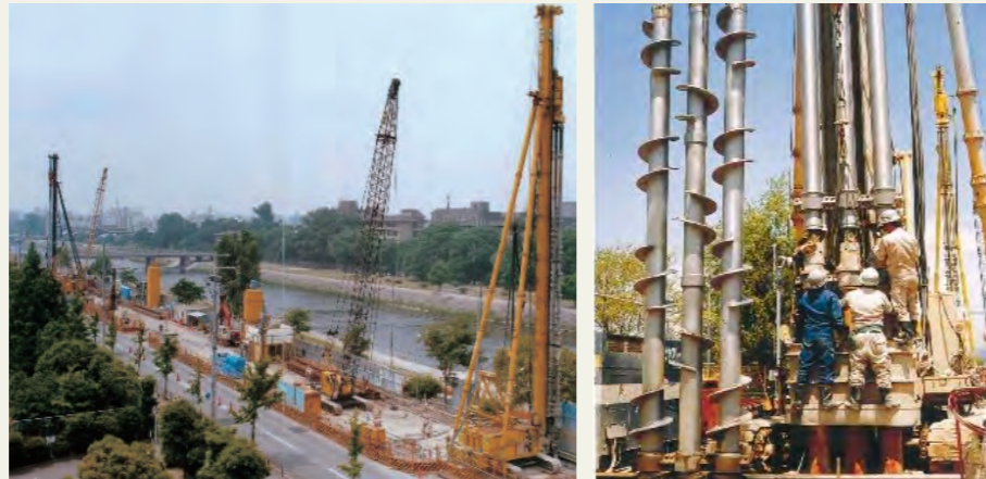
写真4 土留壁施工状況（左）とSMW工法掘削機（右）
