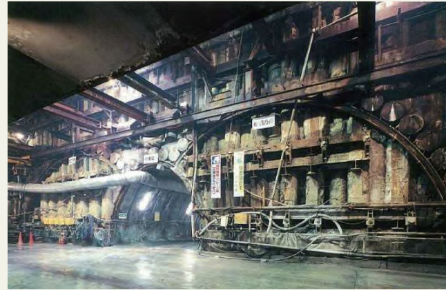
写真2 中央環状王子線 NATM工法実施状況
