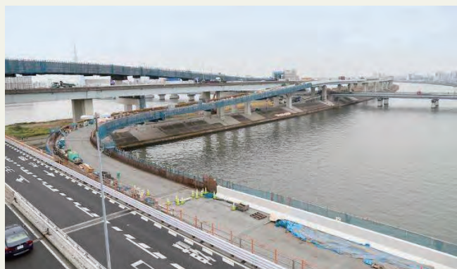
写真8 小松川JCT 施工状況 2018（平成30）年撮影
