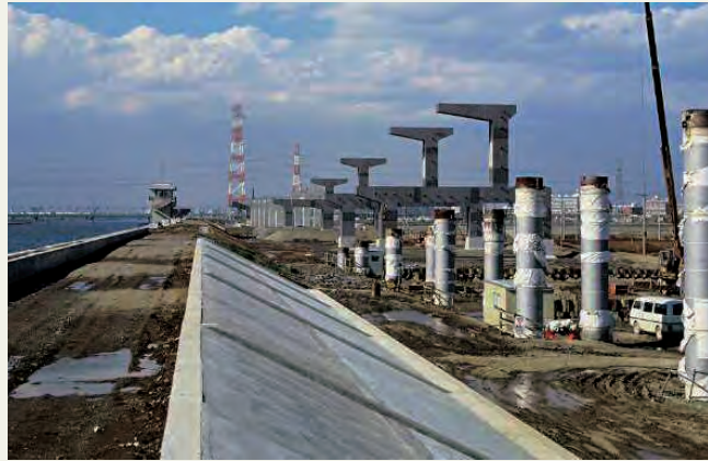
写真1 葛飾江戸川線 中堤での施工状況
