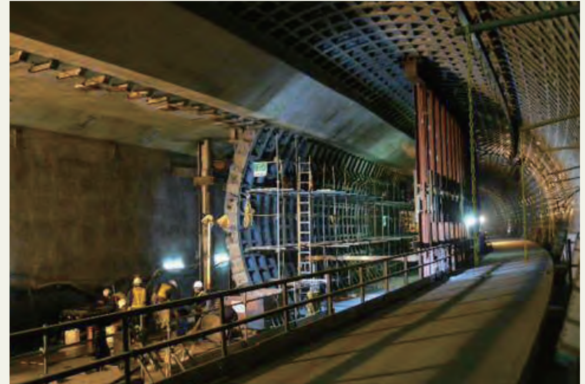
写真3 切開き工法（西新宿JCT 合流部）
