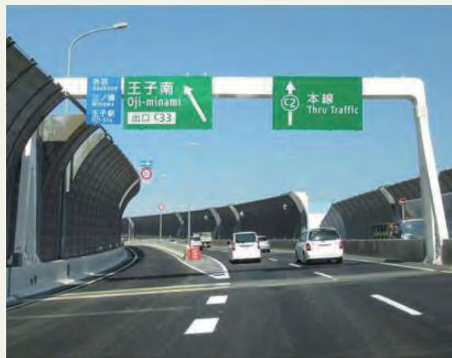
写真5 遮音壁の設置状況
