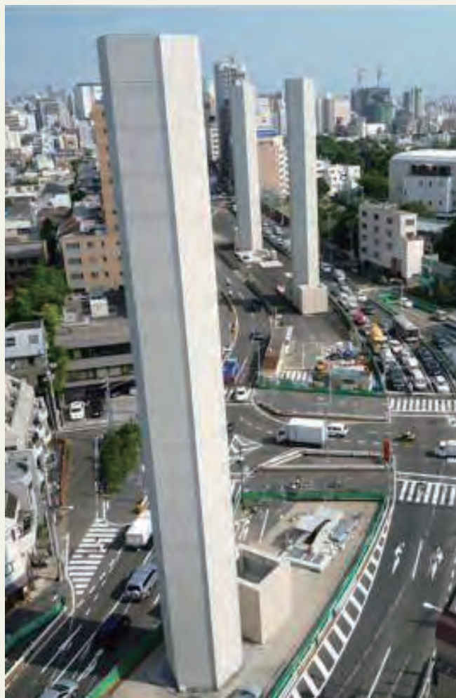
写真6 中央環状線神山町換気所 2010（平成22）年撮影
