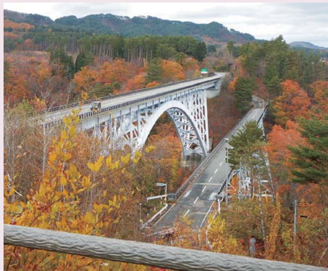
写真2 思案坂大橋と榎木沢橋
