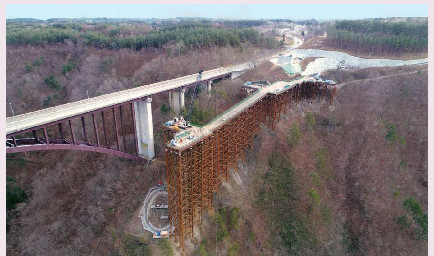
写真5 田野畑道路（新思惟大橋の工事状況）
