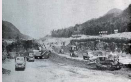
写真18 大型機械による施工
