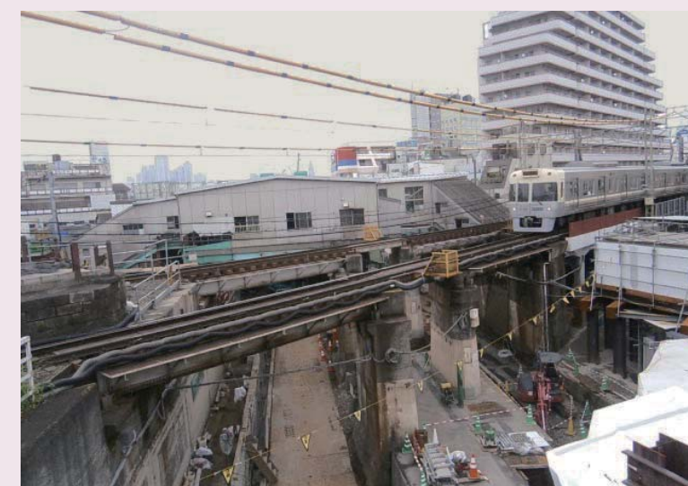
写真4 京王井の頭線の旧橋脚
