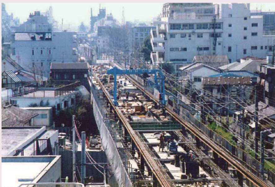
写真2 限られた用地内で高架橋を構築（祖師ヶ谷大蔵～成城学園前駅間）
