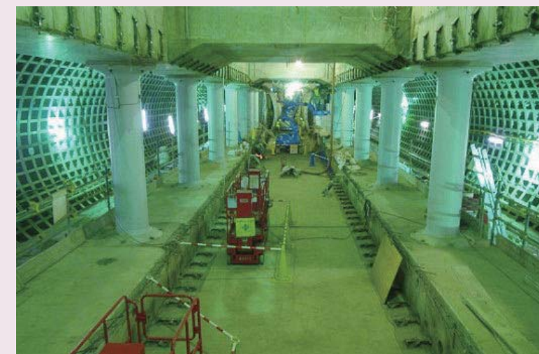
写真3 シールド間切抜け完了状況
