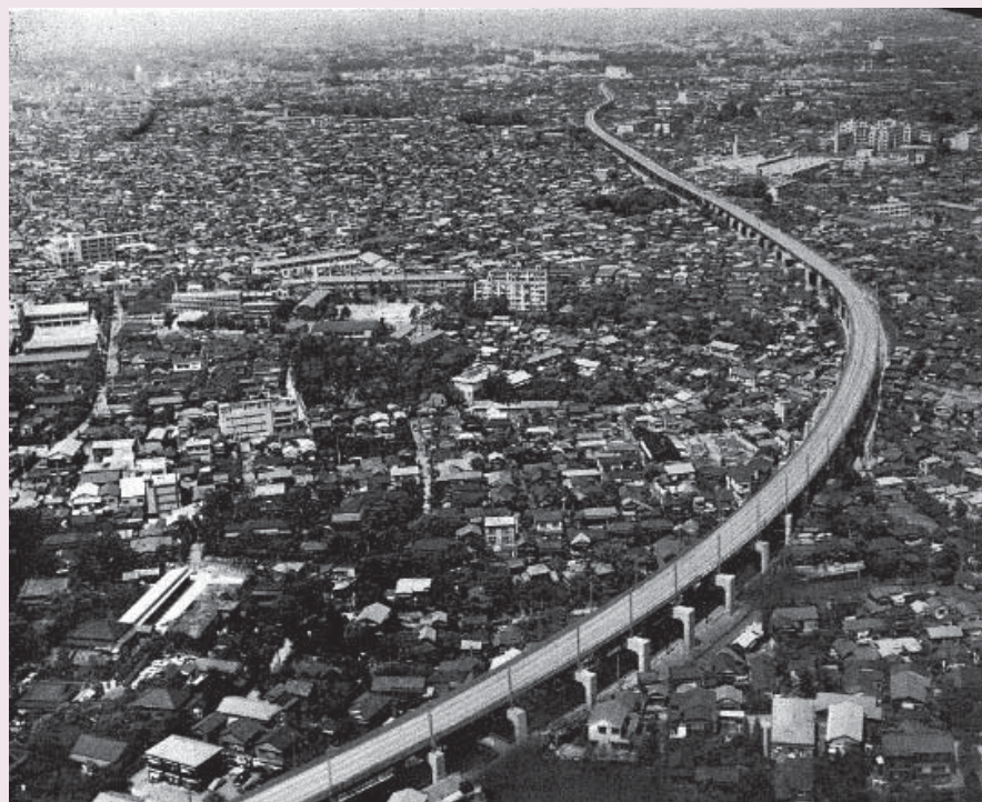
写真2 完成（大井町付近併設高架橋および直上高架橋）
