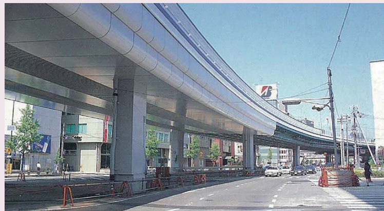
写真3 19径間連続ラーメン橋構造（弁天工区）
