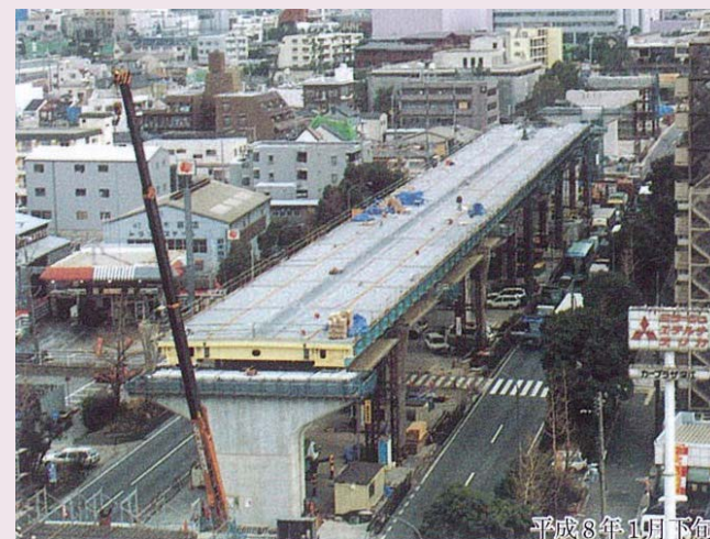
写真6 ピルツ区間の復旧状況
