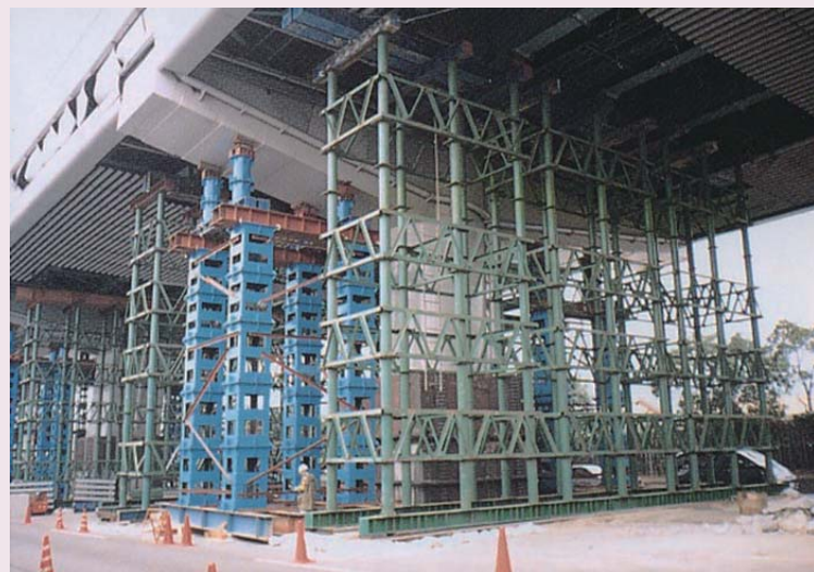
写真2 2次災害防止のための支保工設置状況
