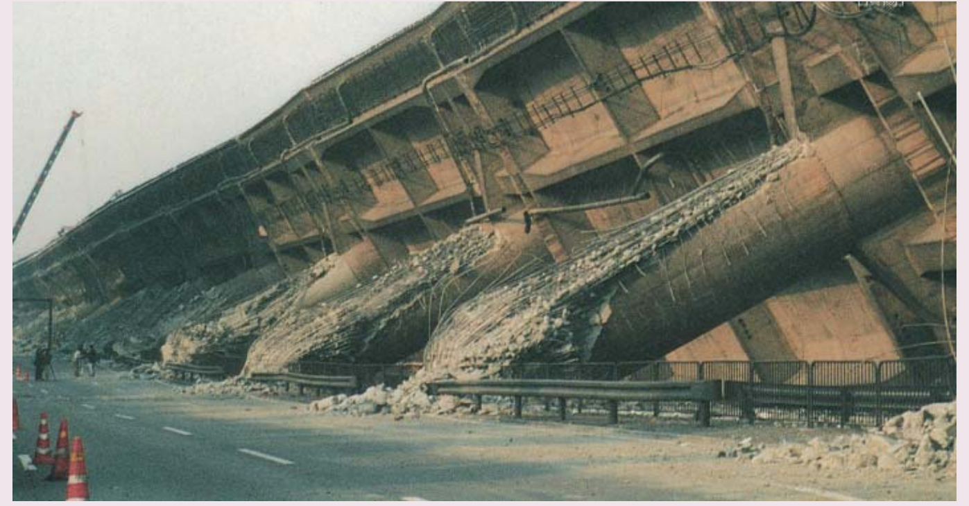
写真1 ピルツ構造区間の倒壊の状況
