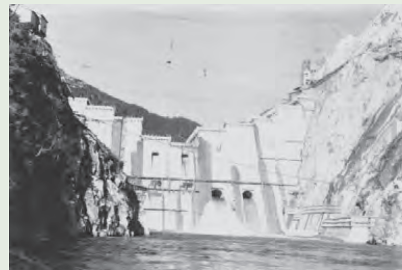
写真1 建設中の佐久間ダム(一次湛水終了時)
