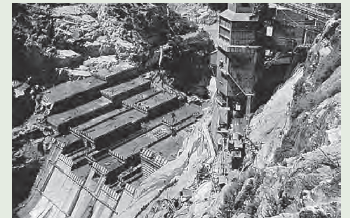
写真6 コンクリート打設全景
