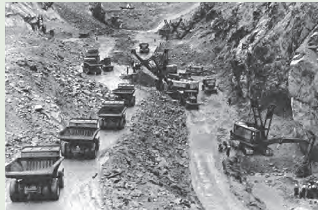
写真4 河床掘削状況
