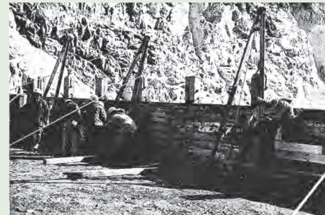
写真5 手巻きウィンチによる型枠スライド
