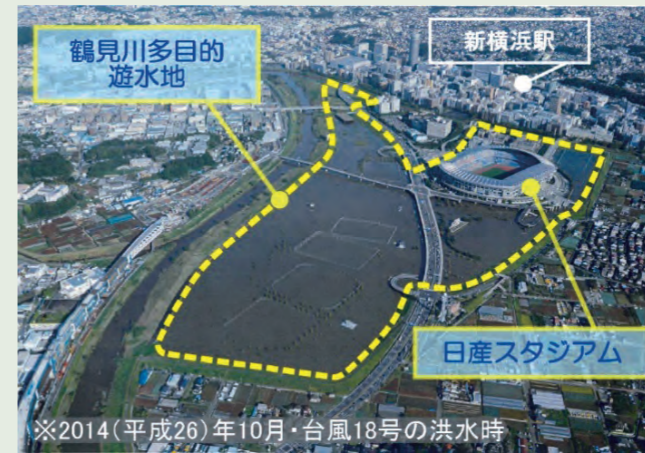
写真4 洪水時の鶴見川多目的遊水地と日産スタジアム
