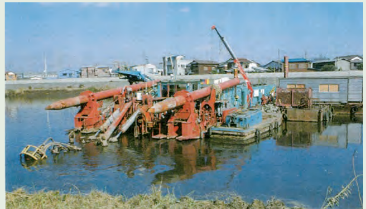
写真2 ポンプ浚渫船「つるみ」
