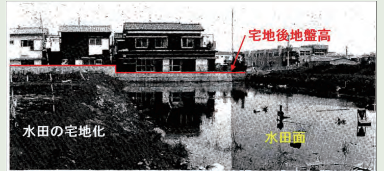
写真1 宅地造成のための盛土
