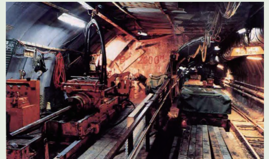
写真2 先進導坑での水平先進ボーリング
