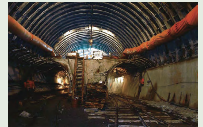
写真1 本坑海底部の施工状況
