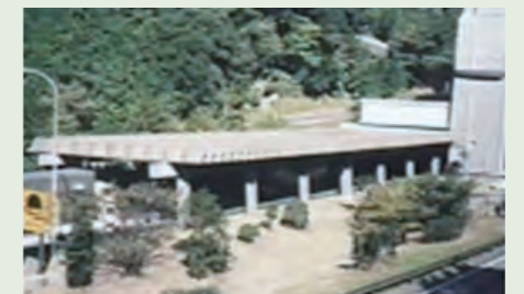
写真13 日本坂トンネル
