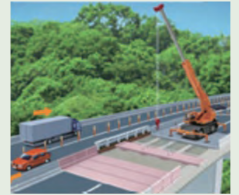
写真24 橋梁の床版の取替え
