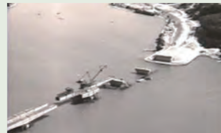
写真15 浜名湖橋の施工
