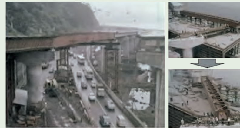
写真17 由比地区の薩埵高架橋の施工
