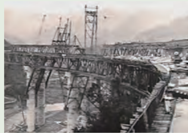
写真16 酒匂川橋の施工
