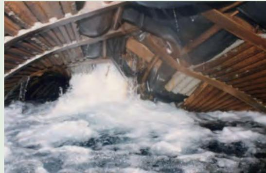
写真3 大出水時の支保工圧壊状況
