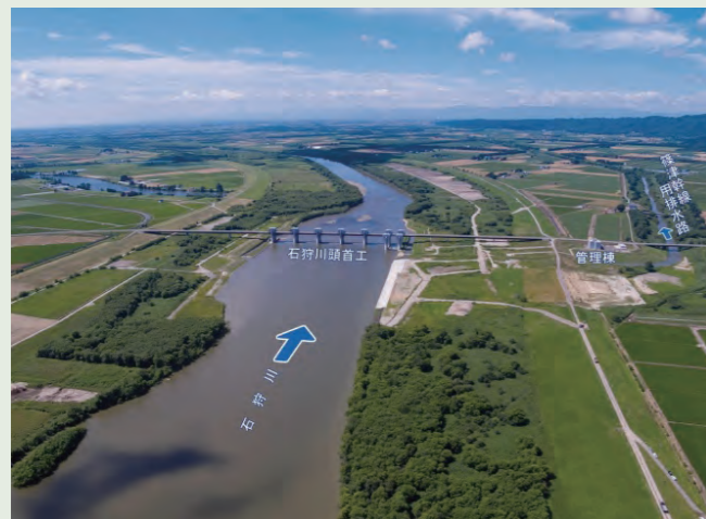
写真5 改築された石狩川頭首工の全景 (堰長257m、最大取水量37.49m 3 /s)
