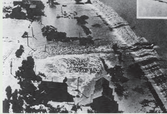
写真1 石狩川1975（昭和50）年洪水の越水状況
