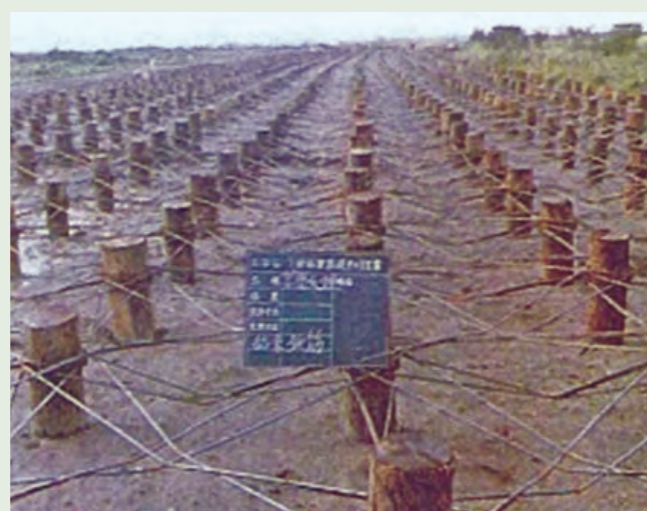
写真6 パイルネット木杭打込み・鉄筋連結
