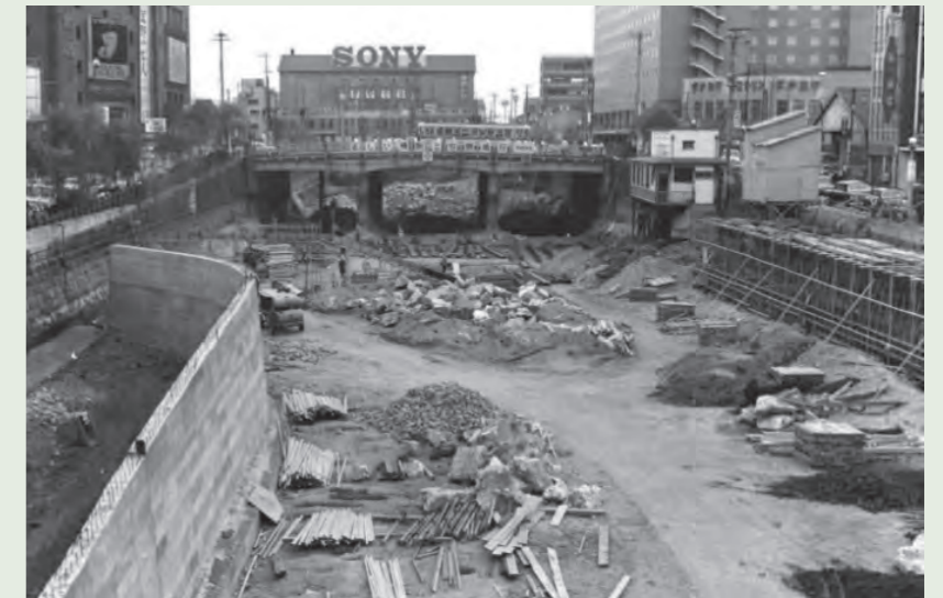
写真3 築地川・楓川区間（掘割構造）
