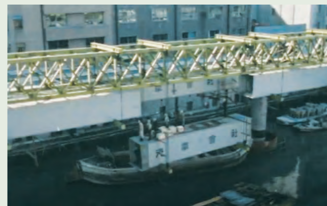
写真7 エレクショントラス併用移動式吊り上げ工法
