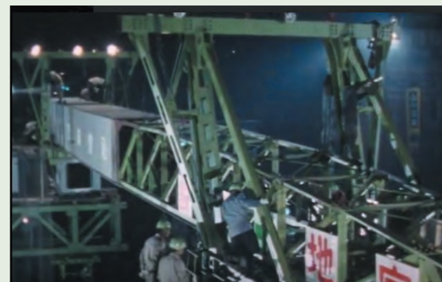
写真9 主桁架設手延べ工法
