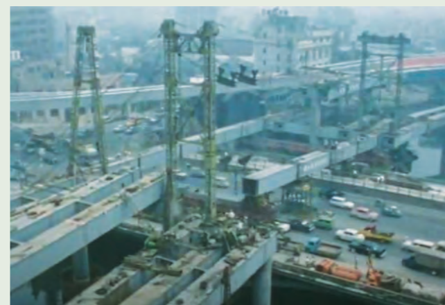
写真8 仮受けベント併用ケーブルクレーン工法
