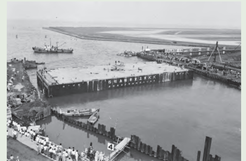
写真2 羽田トンネル（沈埋函工法）
