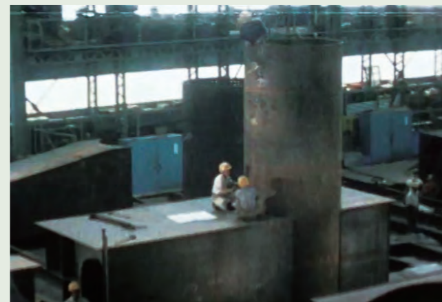
写真6 橋脚隅角部製作状況
