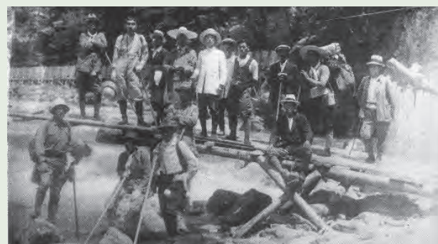
写真10 田代川発電所工事を視察する松永安左エ門翁（上段左から2人目）
