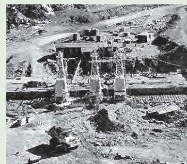
写真17 イコス施工状況全景
