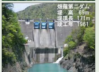
写真2 井川、畑薙第一・第二と3基連なる中空重力式ダム
